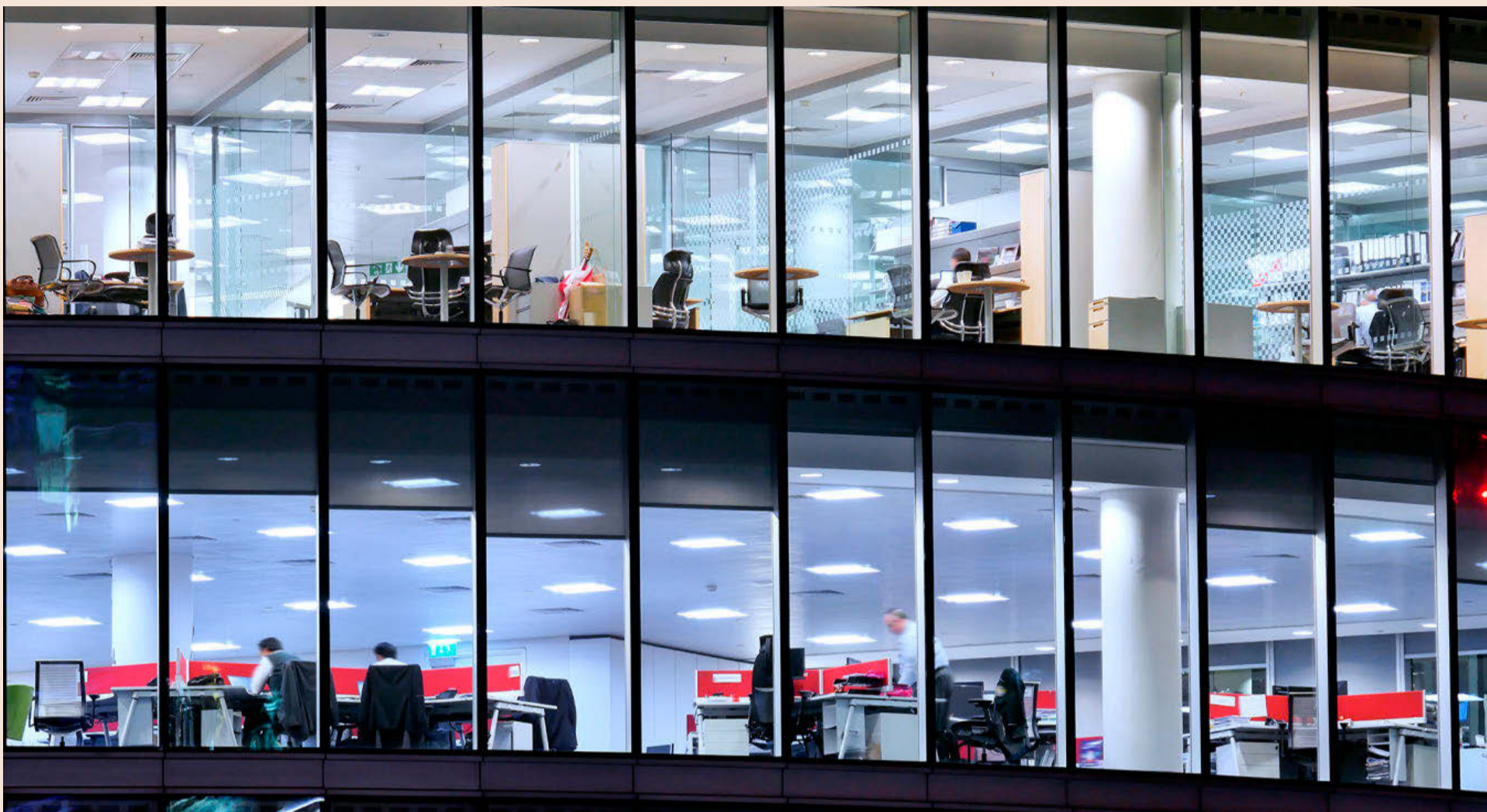
Los edificios acristalados son eficientes, pues favorecen la iluminación natural, pero es conveniente tener en cuenta que pueden presentar problemas de aislamiento. /SHUTTERSTOCK
